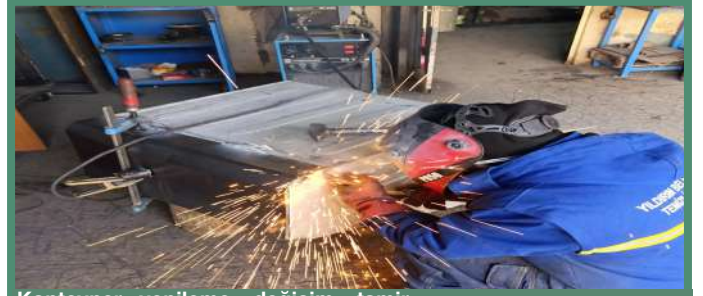
Konteyner yenileme, değişim, tamir, bakım ve onarım
