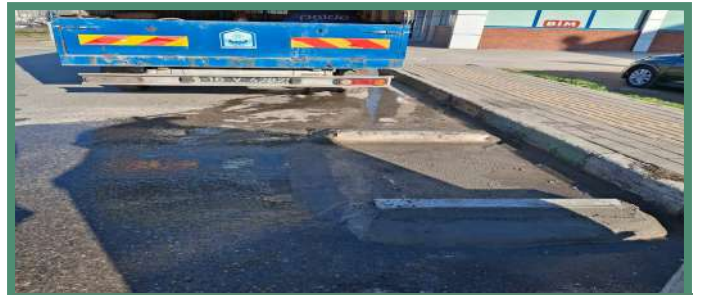
Konteyner cep yeri yapım çalışması
